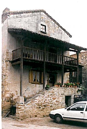
Avant-corps. Dans l'architecture traditionnelle, on rencontre les "aitres", parfois incorporés à la toiture. On peut s'en inspirer pour réaliser des balcons pleins.
