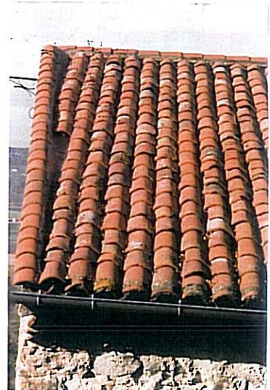
Pose de tuile de récupération sur forme. Divers procédés existent. On doit veiller à ce que les tuiles ne glissent pas.
